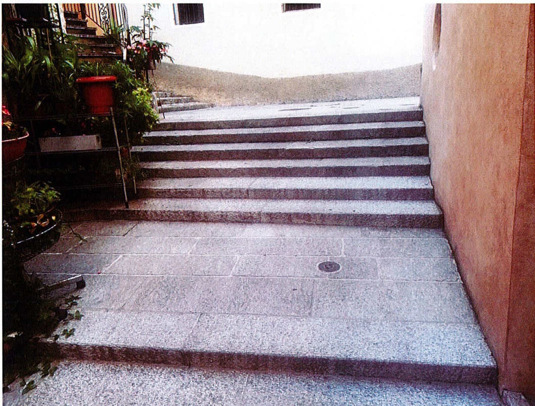
Figura 5: esempio pavimentazione in lastre - vista generale
