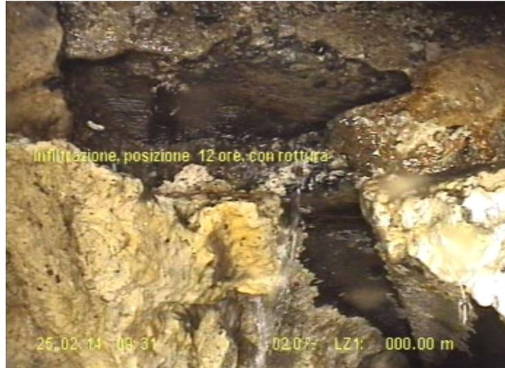
Foto 4: infiltrazioni presso pozzo 122770, 25.02.2014 (ispez. TV PGS), livello lago a 270.70 mslm
