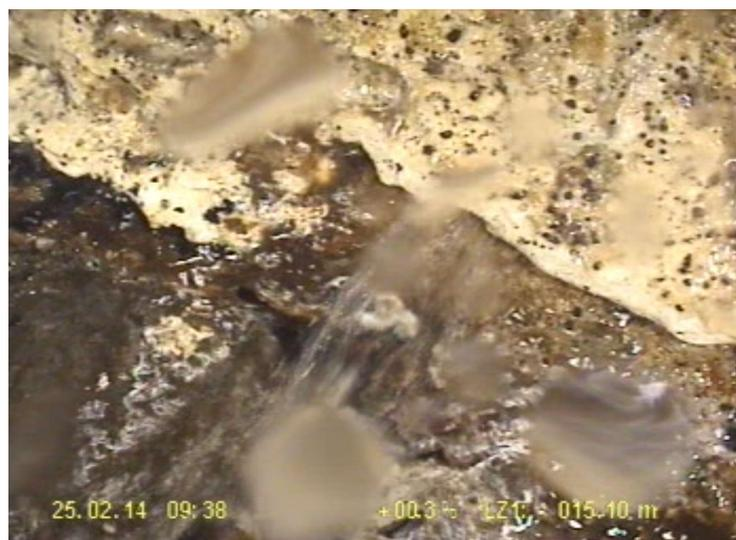
Foto 3: infiltrazioni presso pozzo 122770, 25.02.2014 (ispez. TV PGS), livello lago a 270.70 mslm
