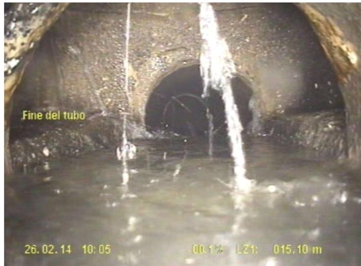
Foto 2: infiltrazioni presso pozzo 122780, 26.02.2014 (ispez. TV PGS), livello lago a 270.68 mslm
