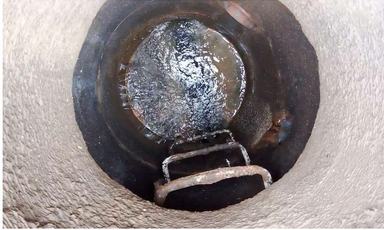
Foto 1: infiltrazioni presso pozzo 122790, 16.05.2023, livello lago a 270.61 mslm
