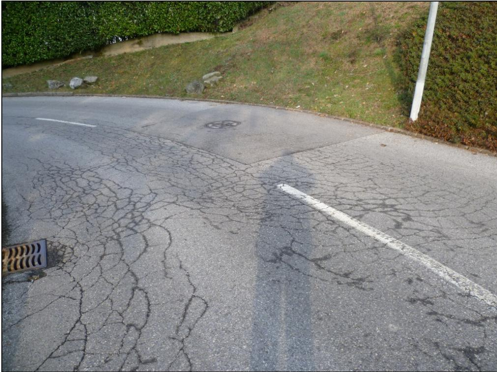
FOTO 3: dettaglio fessurazioni pavimentazione
