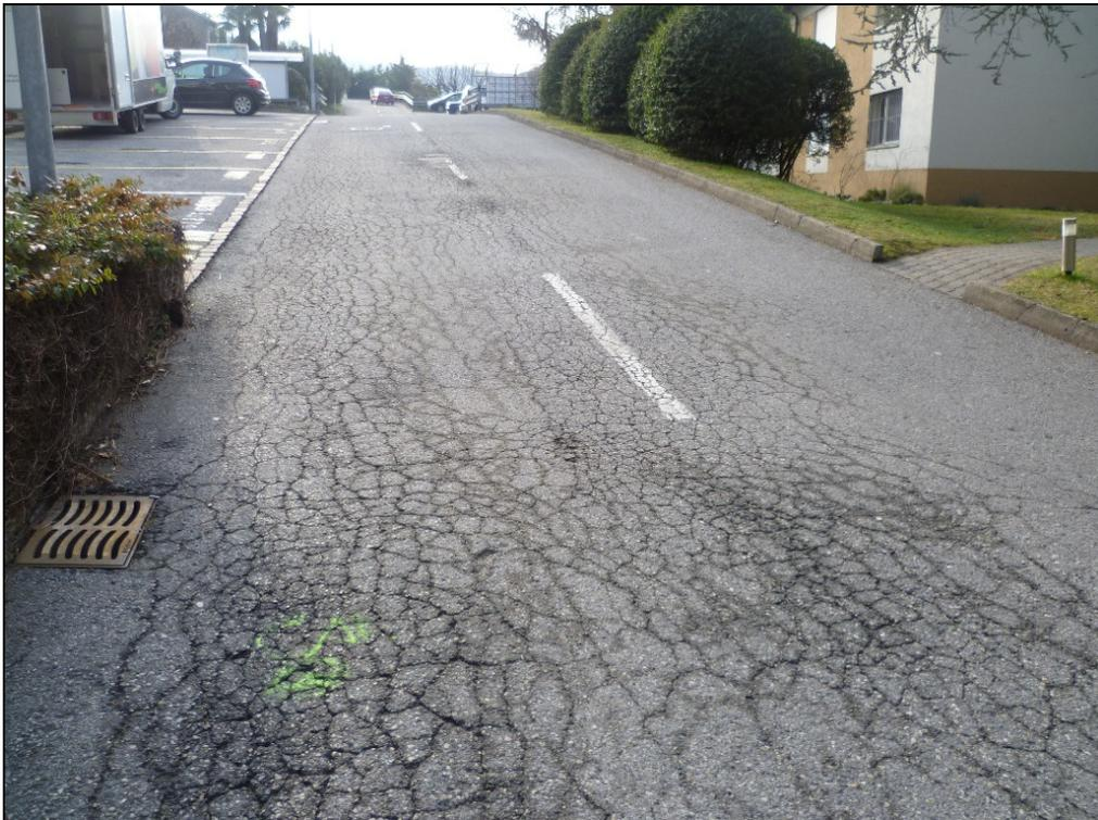
FOTO 6: dettaglio fessurazioni pavimentazione
