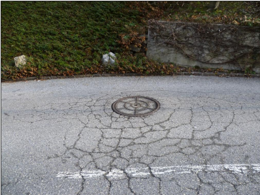
FOTO 4: dettaglio fessurazioni pavimentazione
