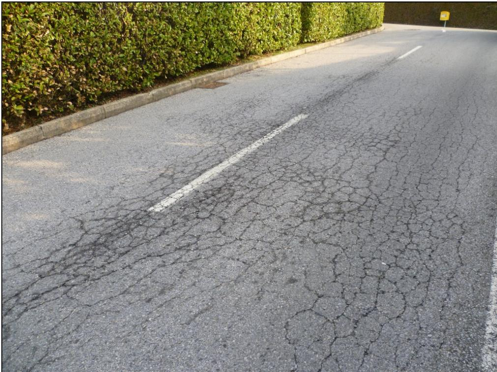
FOTO 14: dettaglio fessurazioni pavimentazione
