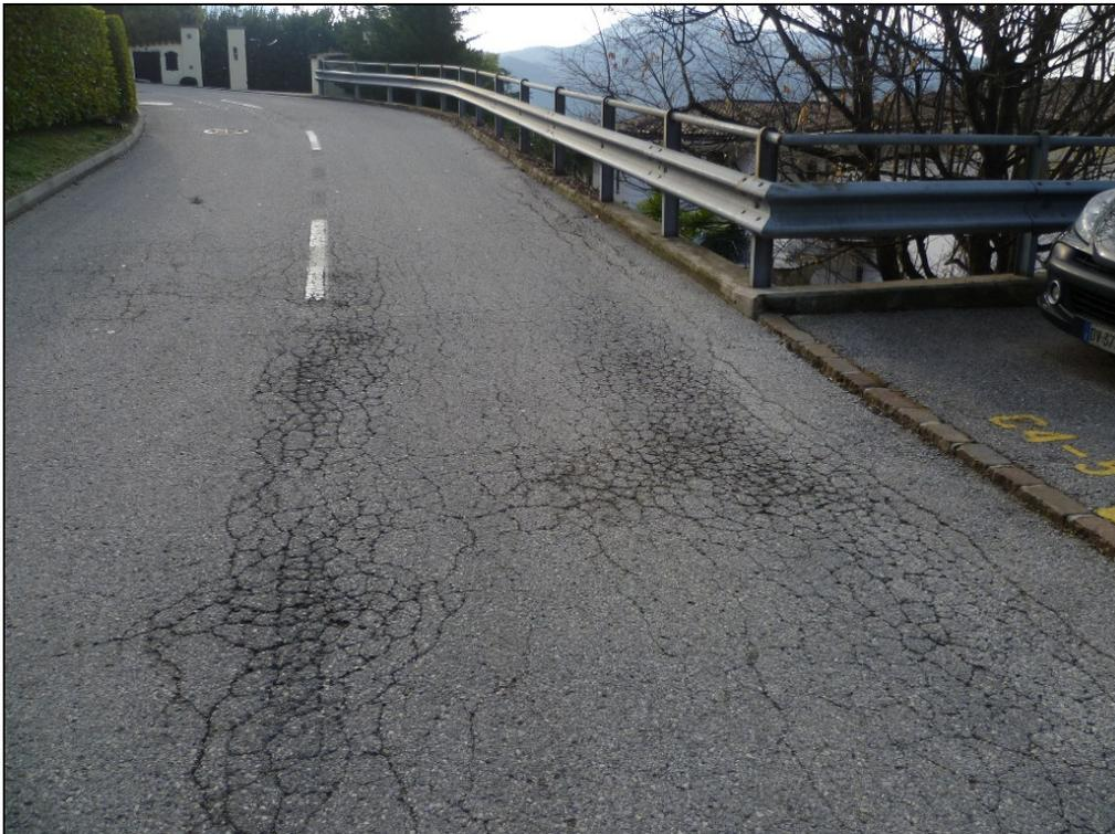
FOTO 10: dettaglio fessurazioni e cedimento pavimentazione
