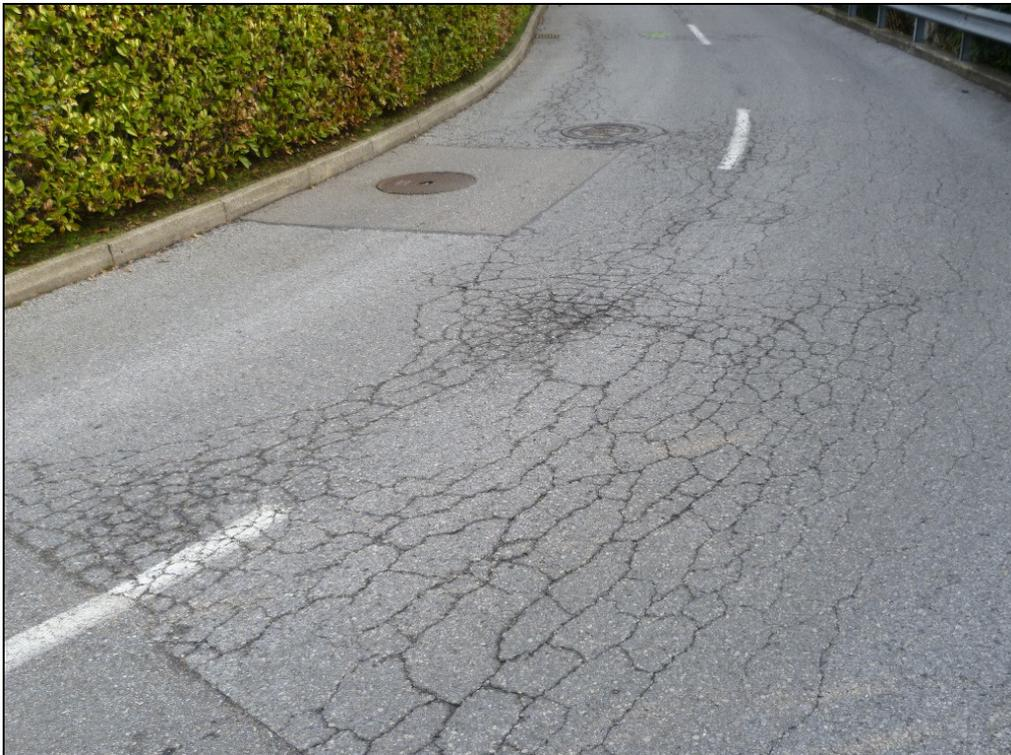
FOTO 12: dettaglio fessurazioni pavimentazione
