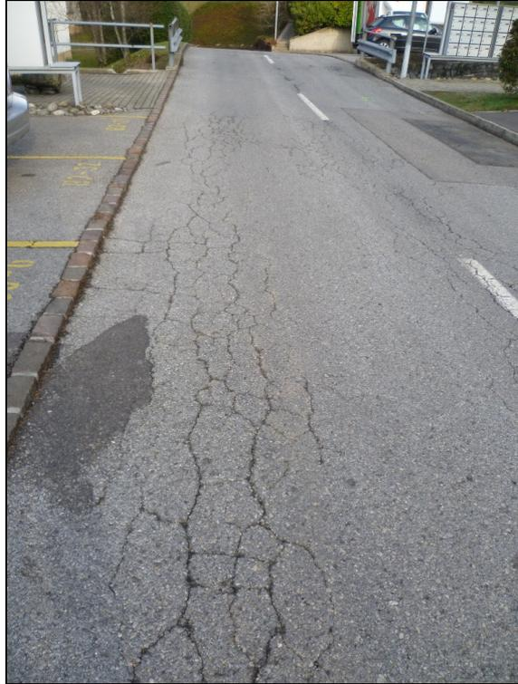
FOTO 9: dettaglio fessurazioni pavimentazione
