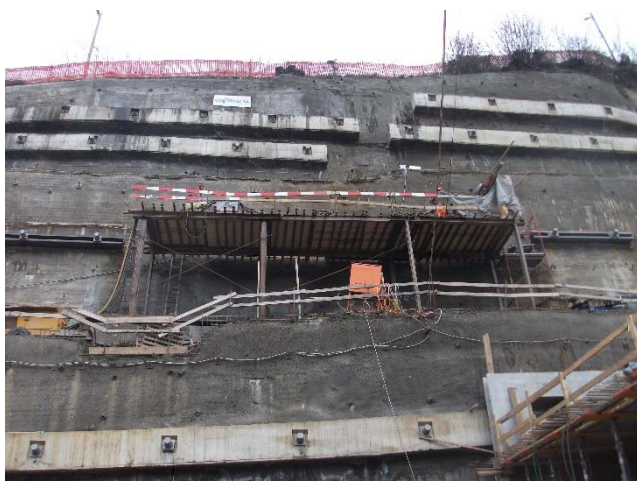
Fronte nord-est: allestimento ponteggio
