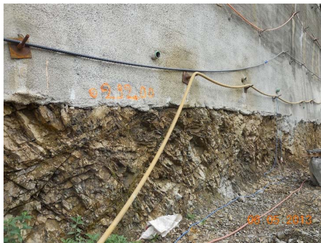
Dettaglio scavo d'abbassamento in roccia
