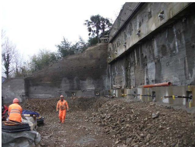
Fronte sud-ovest: vista ancoraggi angolo
