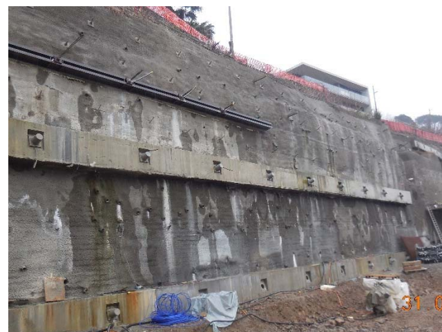
Fronte sud-ovest: vista trave di testa ancoraggi
