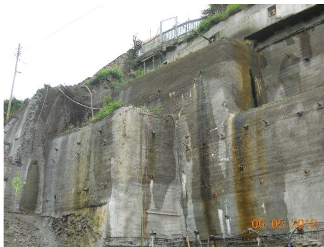
Fronte sud-ovest e in alto dettaglio muro sentée Murinasc
