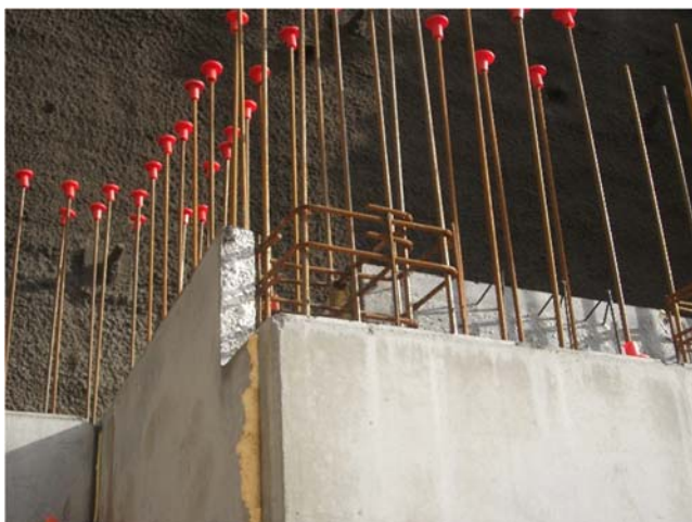
Fronte nord-est: particolare collegamento muri perimetrali
