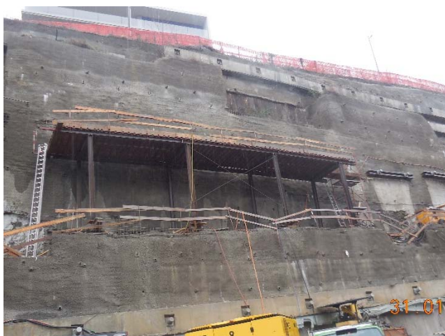
Zona centrale: allestimento ponteggio
