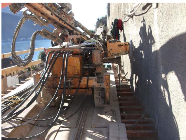
Fronte nord-est: macchinario sul ponteggio
