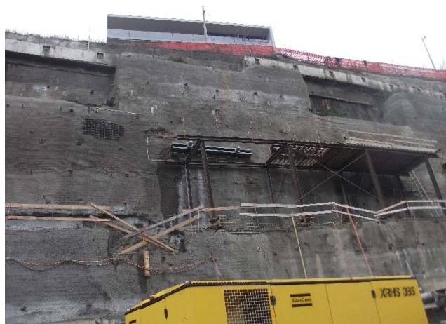
Zona centrale: allestimento ponteggio
