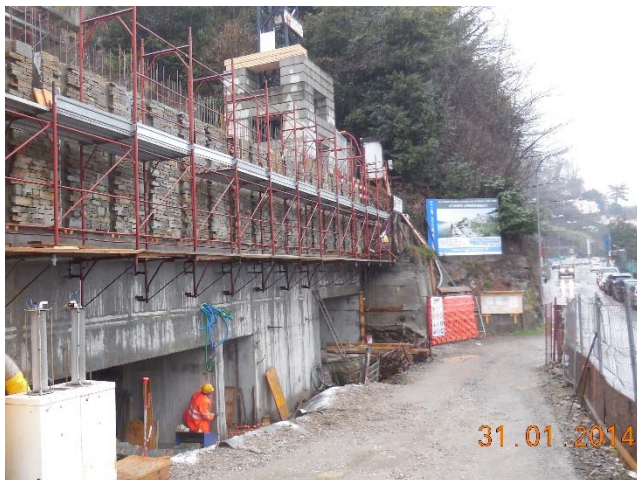
Fronte nord-est: ingresso autosilo
