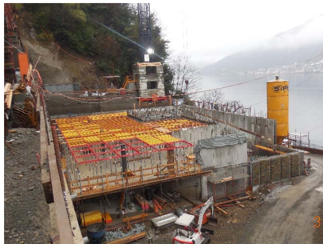
Fronte nord-est: cassero seconda soletta autosilo
