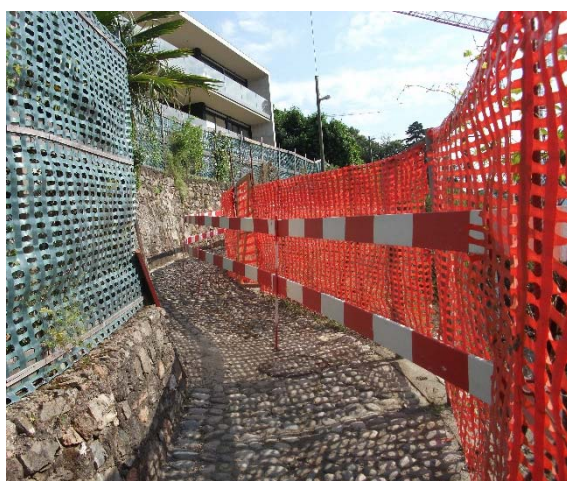
Messa in sicurezza del sentèe dala Vigna
