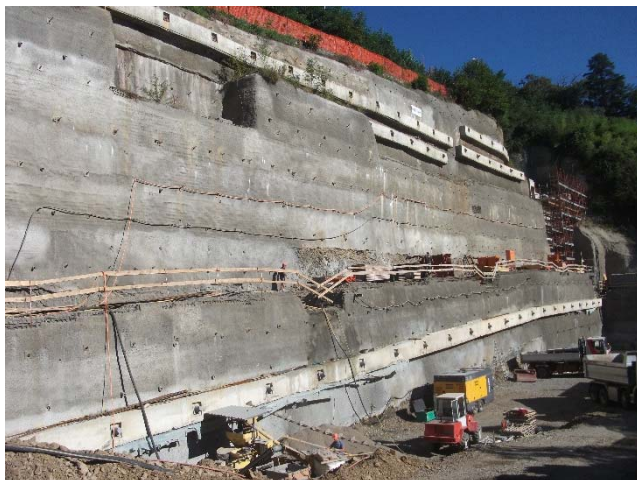
Parte centrale lato sentèe dala Vigna
