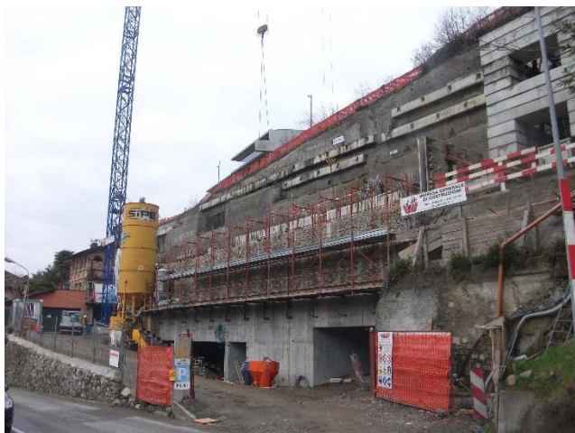
Fronte nord-est: ingresso autosilo
