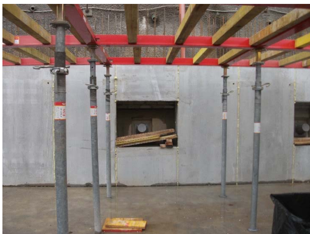
Fronte nord-est: particolare risparmi per ispezione
