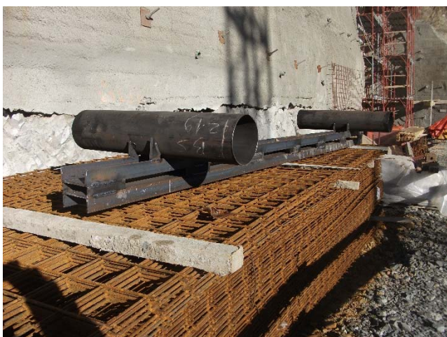
Fronte nord-est: particolare elemento della nuova trave
