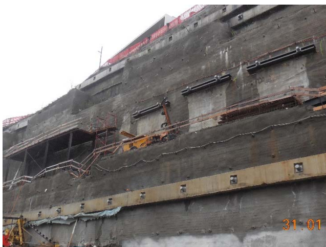
Zona centrale: vista generale ancoraggi
