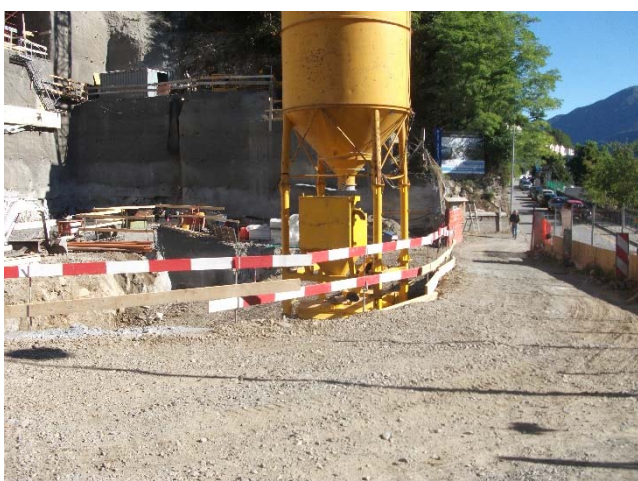
Nuova pista di cantiere
