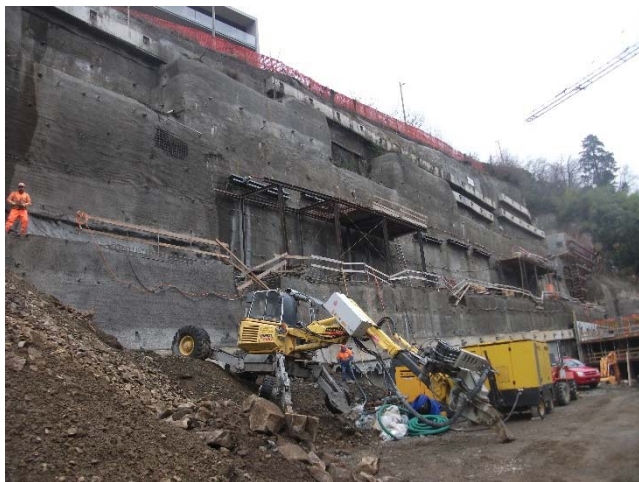
Zona centrale: vista generale ancoraggi
