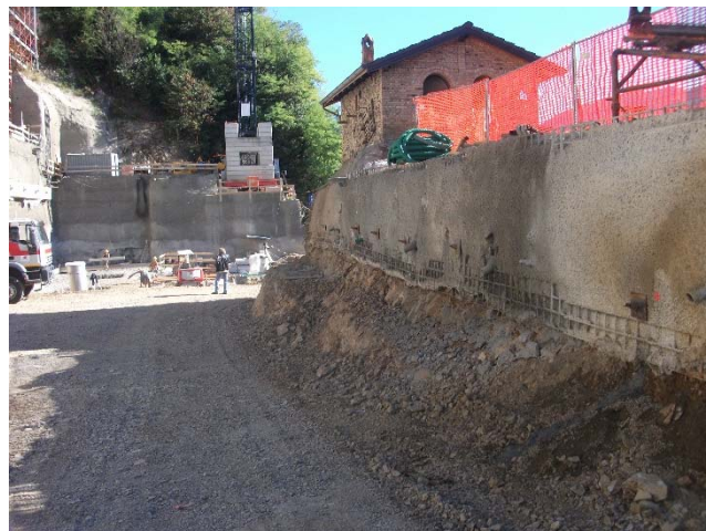
Parte centrale lato proprietà Bombelli
