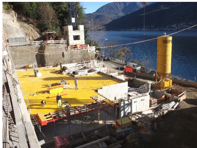
Fronte nord-est: cassero prima soletta autosilo
