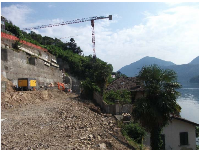
Apertura del cantiere lato lago
