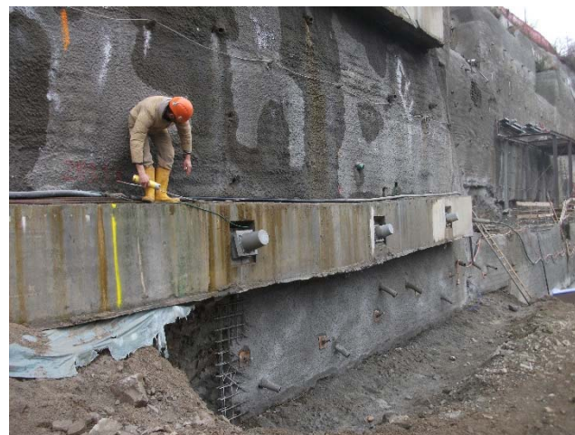
Fronte sud-ovest: avanzamento scavo sotto trave esistente
