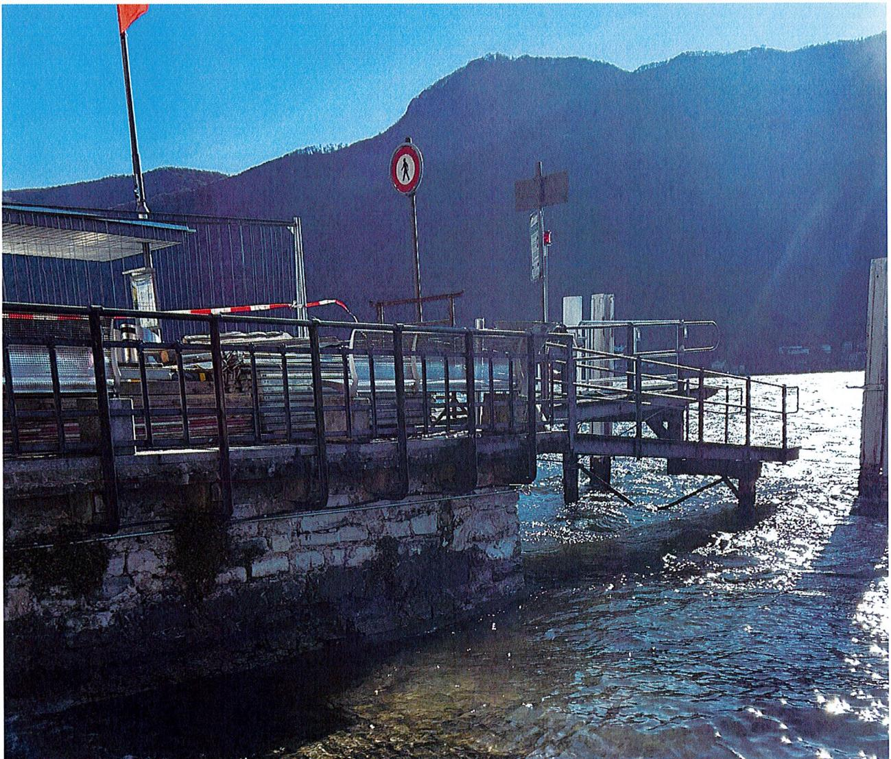
*Situazione post-intervento sistemazione manufatto, rimozione respingenti e posa di due pali provvisori*
